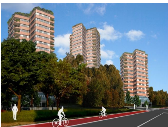
5- Demolizione e costruzione terzo edificio
